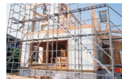
2階壁パネル施工
