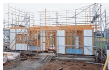
1階壁パネル施工
