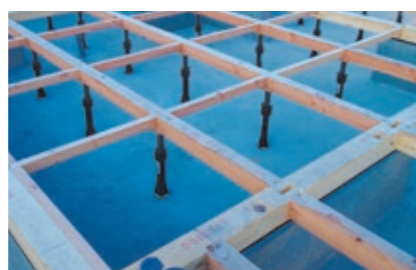
1階床組(土台)施工
