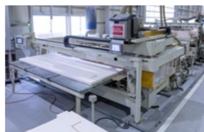
断熱材カット
