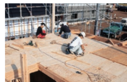
2階床パネル施工
