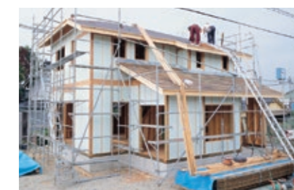
屋根材・サッシ枠施工
